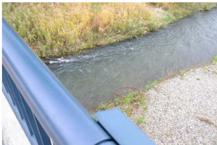
3-② 神楽橋左岸水路中州側-121028_115607_0 1024 × 678 24bit
